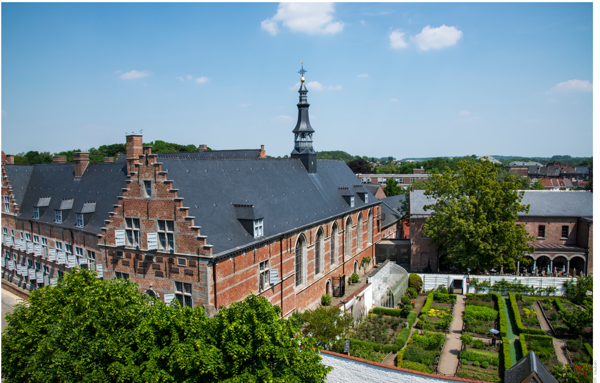
Vue aérienne du site de l'Hôpital Notre-Dame à la Rose.
